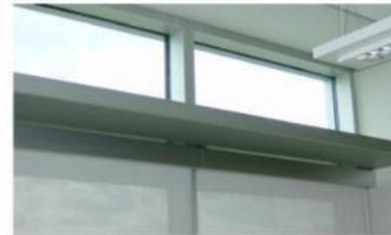
(ACIMA) Alternativa sugerida para estudo incluindo light shelf e vidro inferior com reduzida transmitância luminosa.
